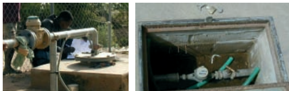
Photo 29 et 30 Compteur de tête type Woltman et compteur de vitesse à cadran sec. On peut remarquer, pour ce dernier, le rétrécissement de diamètre de tuyauterie
