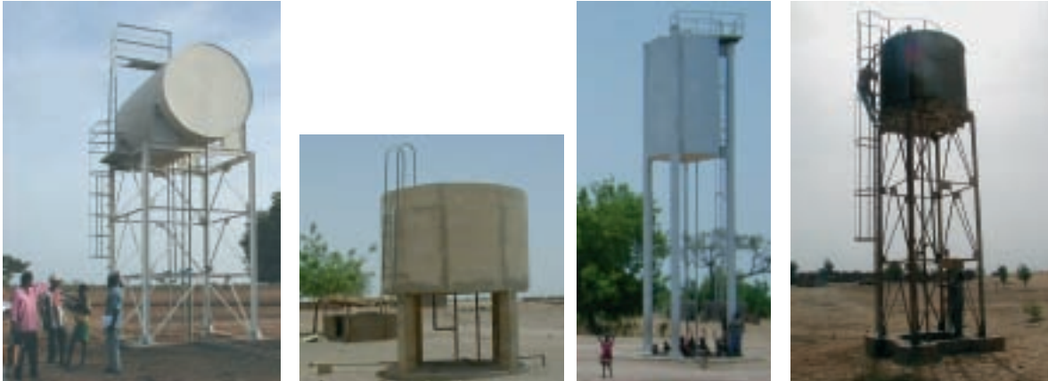
Photos 9, 10, 11 et 12 Différents types de formes et de tailles de hauteur de réservoir
