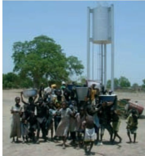
Photo 6 Au Burkina Faso, une hauteur de réservoir ici bien trop excessive
