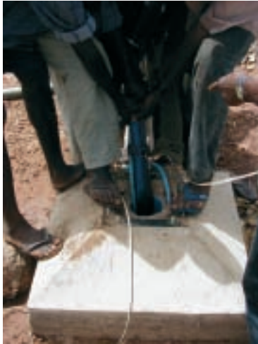
Photo 36 Extraction manuelle d'une pompe lors d'une visite de maintenance au Mali
