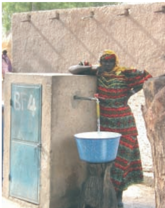
Photo 5 Borne-fontaine au Niger (remarquez le support bassine improvisé)
